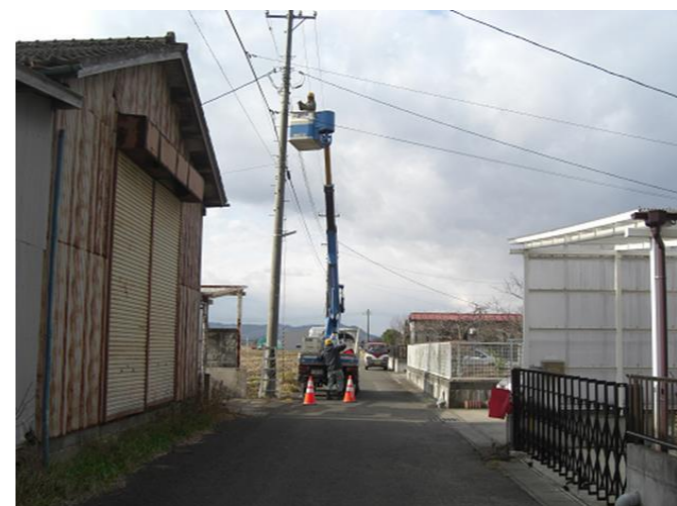
町内LED防犯灯の設置工事
