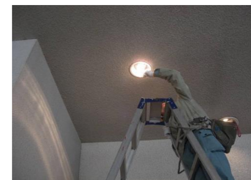
非常照明器具の取付
