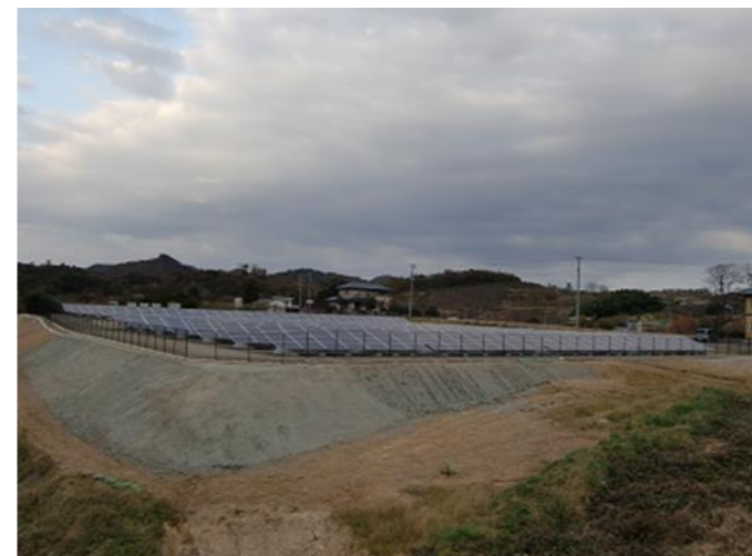
太陽光発電所(日幸電機株式会社)
