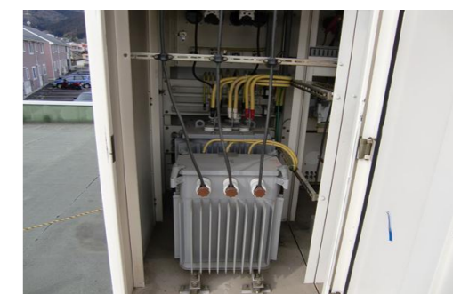
高圧油入変圧器の設置
