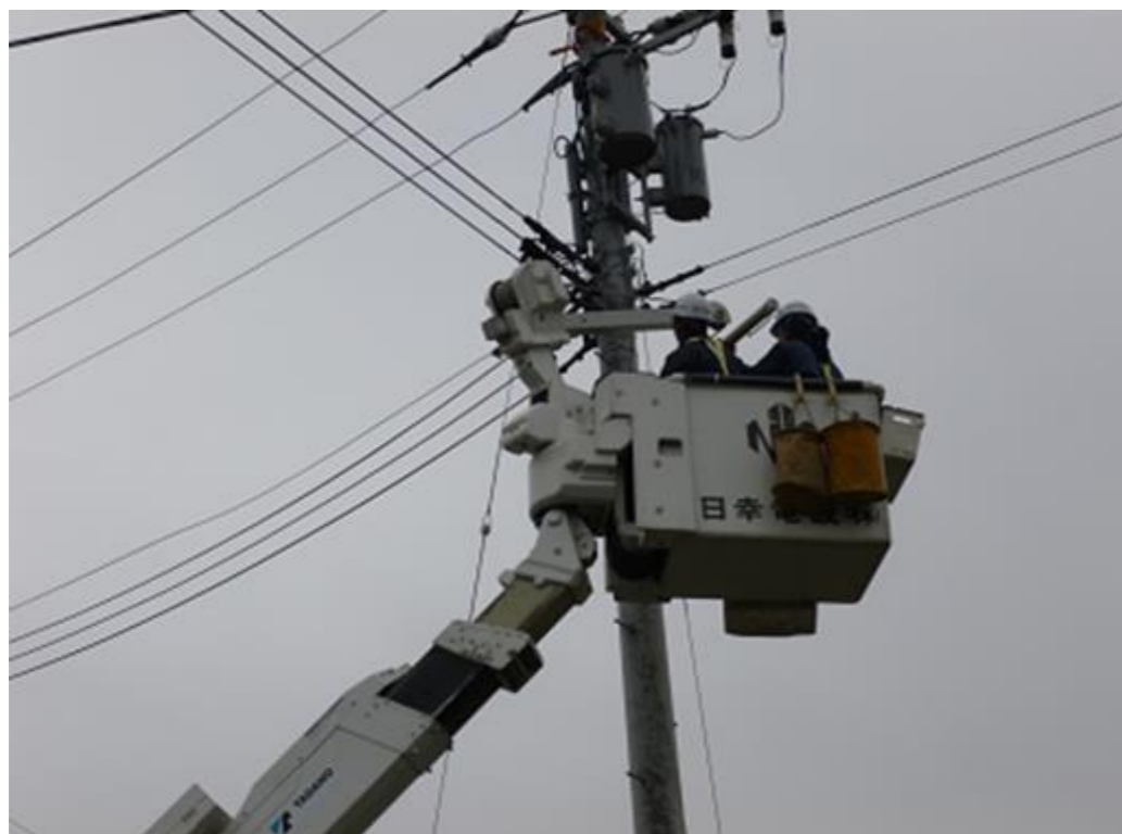
高所作業車による作業
